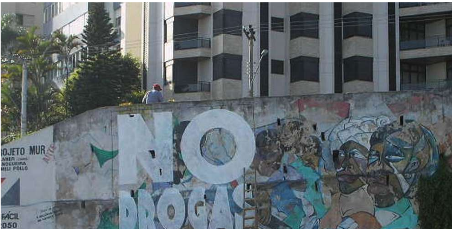
Il. 5: Deterioração da arte urbana mural – Grupo MURARTE, 1995. Fonte: Fotografia: Márcia Escorteganha, 2011.
